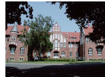
Denkmal Nollendorfplatz: Wohlfahrtsgebäude
