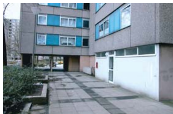
Dunkle, unübersichtliche Durchgangsschotten: Clarenberg-Siedlung
