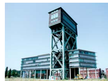
Neue Evinger Mitte: Hammerkopfturm
