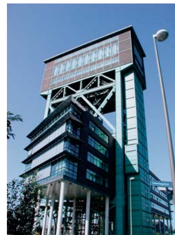
Neue Evinger Mitte: Hammerkopfturm
