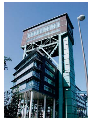
Neue Evinger Mitte: Hammerkopfturm
