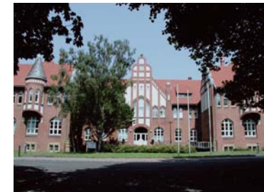
Denkmal Nollendorfplatz: Wohlfahrtsgebäude
