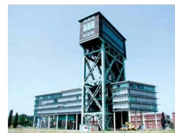
Neue Evinger Mitte: Hammerkopfturm
