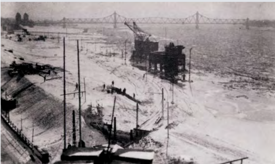
Deichdurchlass der Phoenix-Erzbahn zu den Entladeanlagen
