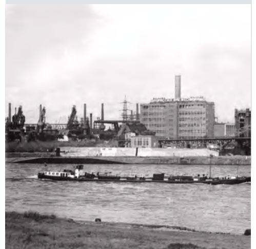
Hochöfen und Kraftwerk von Phoenix-Rheinrohr um 1955
