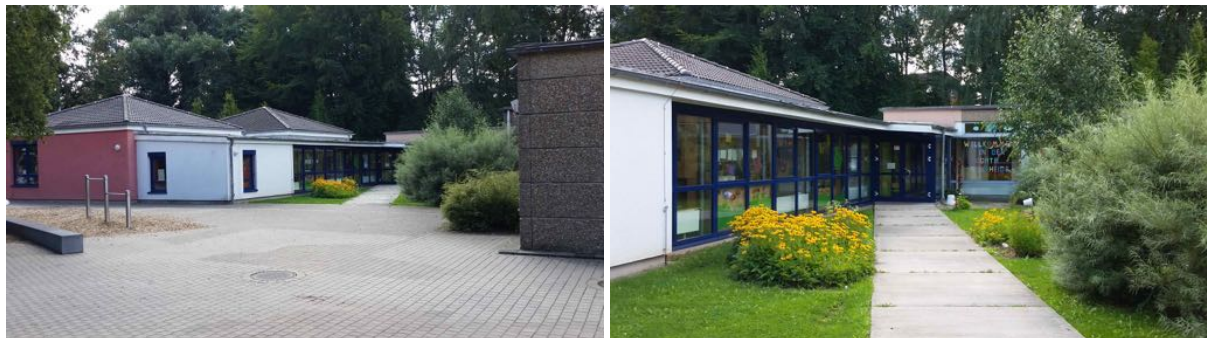
Foto 57 und Foto 58: Eingangsbereich des offenen Ganztags
