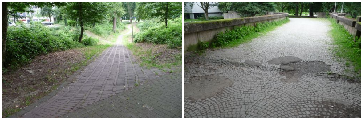
Foto 47 und Foto 48: Fußweg zwischen Schildsheider und Brechtstraße sowie Fußgängerbrücke am Stadtweier
