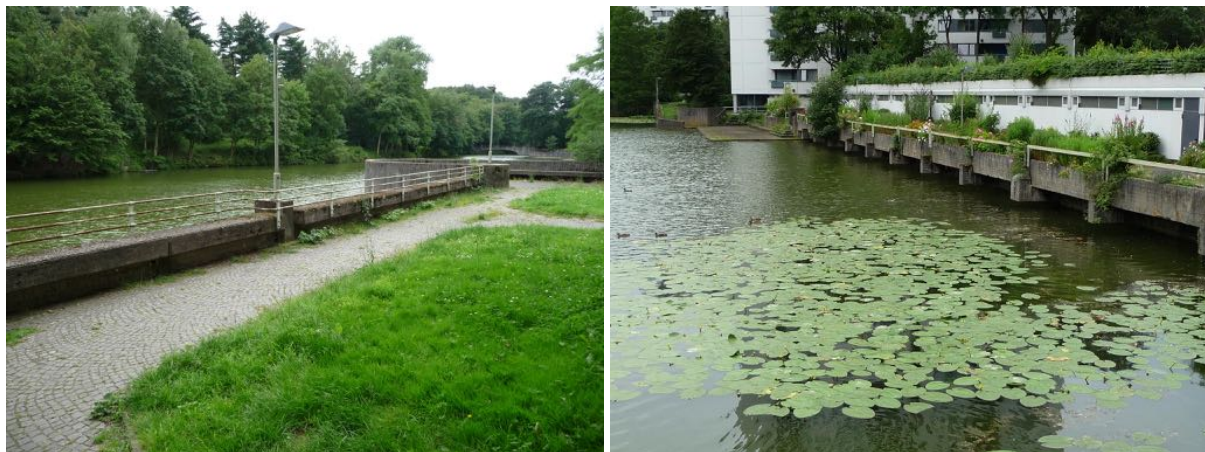
Foto 31 und Foto 32: Uferbefestigung am Stadtweiher - Nordufer
