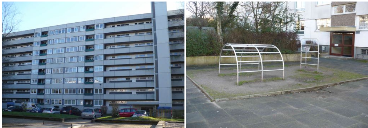
Foto 27 und Foto 28: Gebäudefassaden Eichendorffweg und Wohnumfeld Sandheider Straße
