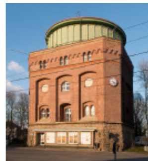
Abb. 29: Wasserturm im Südostviertel
