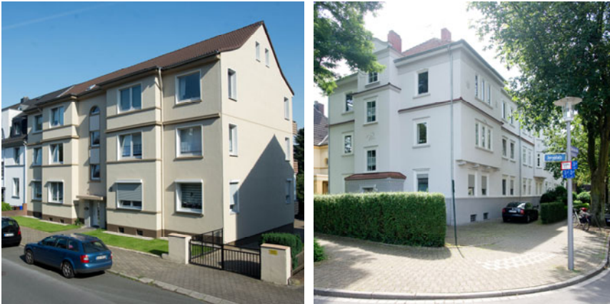
Abbildung 12 Aufgewertete Fassaden im Rahmen des Hof- und Fassadenprogramms
