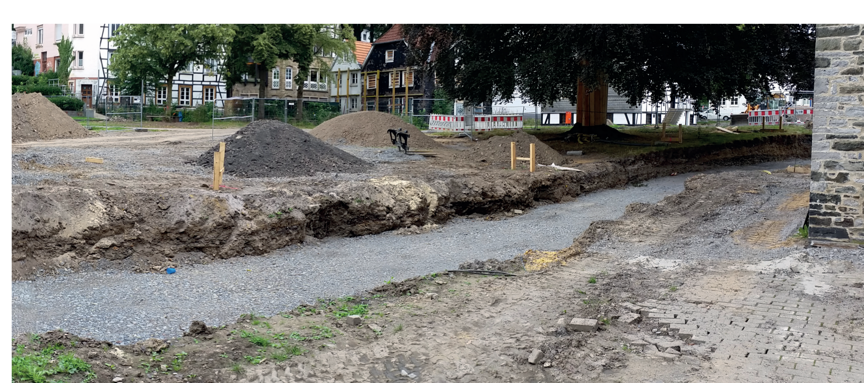
Erdarbeiten der Wasserrinne
