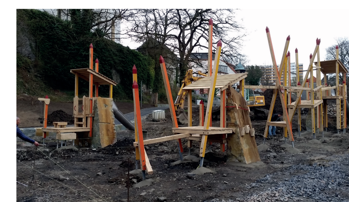
Einbau der Spielgeräte
