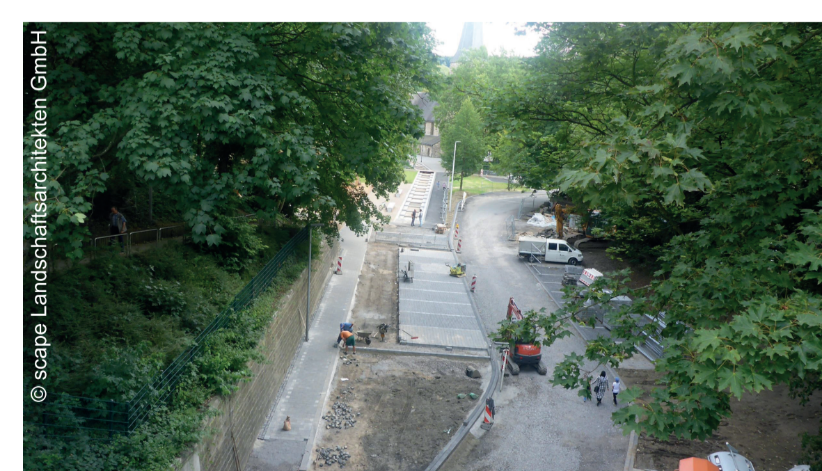
Wegebau in der Inselstraße
