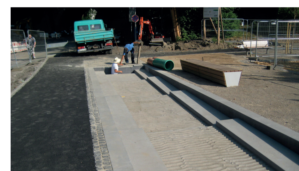
Arbeiten am Auslaufbauwerk
