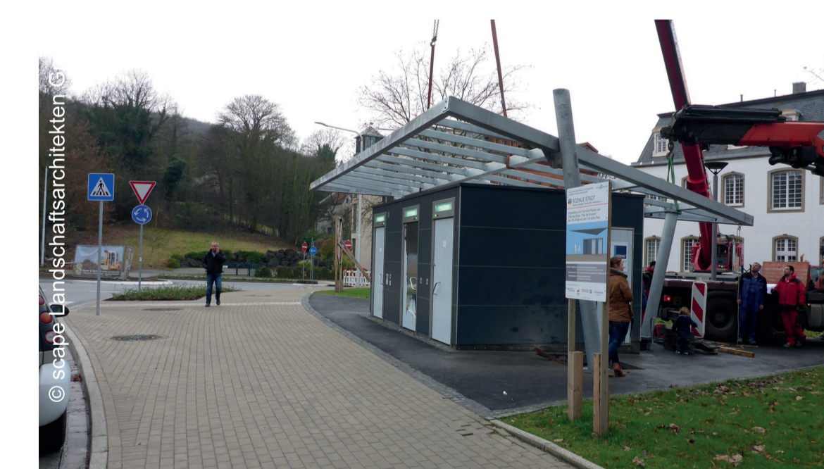
Dachmontage der WC-Anlage
