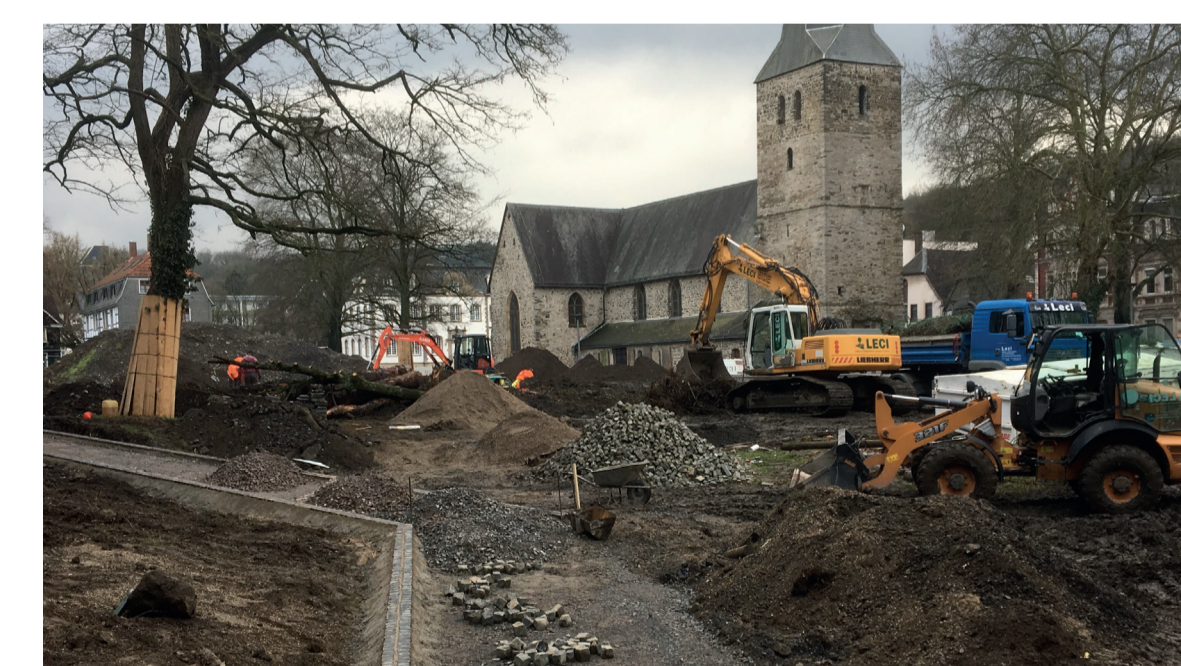
Wegebau mit dahinter liegenden Bodenmatten
