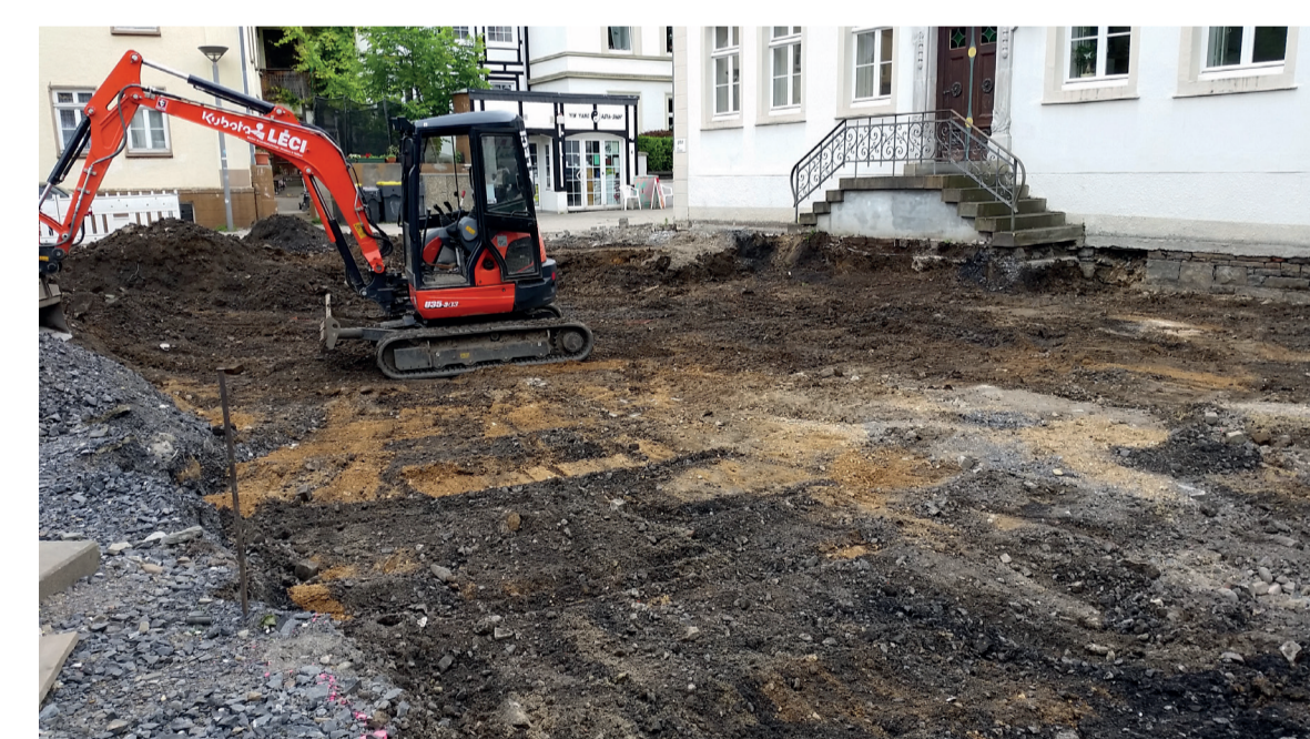
Abbrucharbeiten vor dem Rampelmannschen Haus
