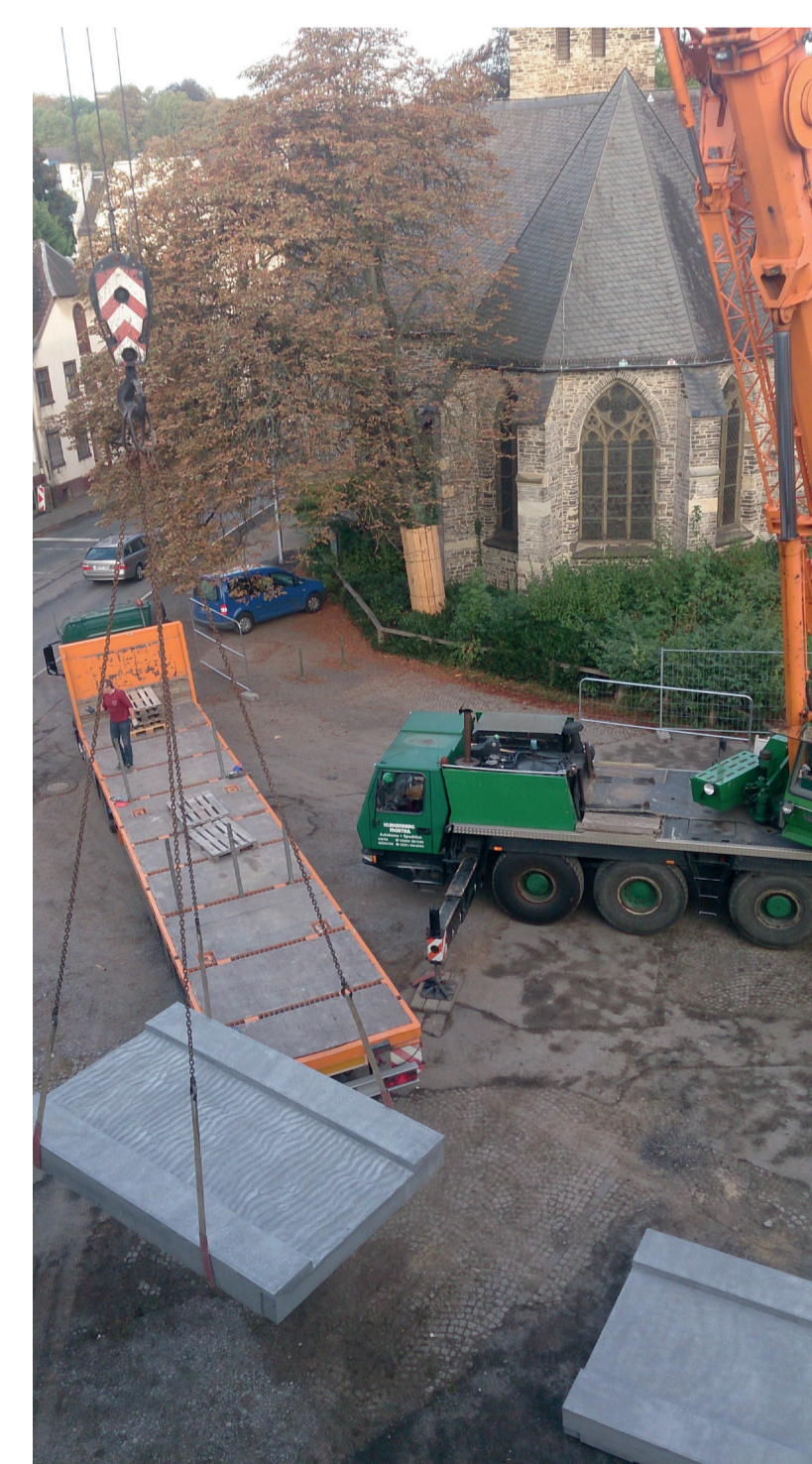
Setzen der Wasserrinne mit einem Autokran
