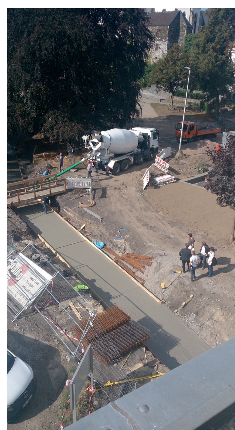
Fundamentbau der Wasserrinne
