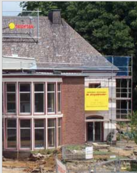
Umgestaltung des Maschinenhauses der Kläranlage Bernemündung
