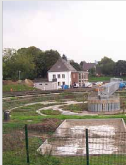
Umgestaltung der Kläranlage Bernemündung
