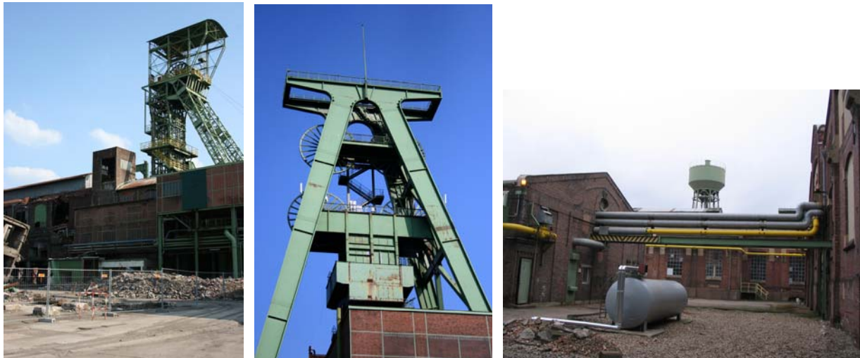
Abb. 29: Fördergerüst Schacht 1, Fördergerüst Schacht 2, Fördermaschinenhaus Schacht 1
