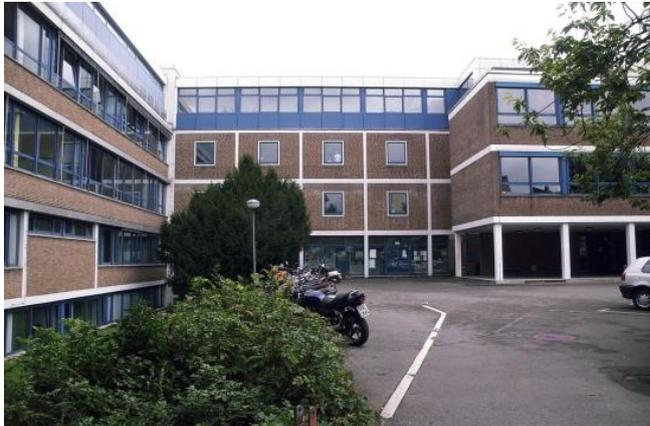
Die Anne-Frank-Gesamtschule besteht aus einem viergeschossigen Schulgebäude mit hohem Fensteranteil und einer Einfach-Turnhalle, die miteinander mit einem Durchgang verbunden sind. Die Gebäude wurden 1956 errichtet. Die 4. Etage wurde 1993 aufgestockt.
